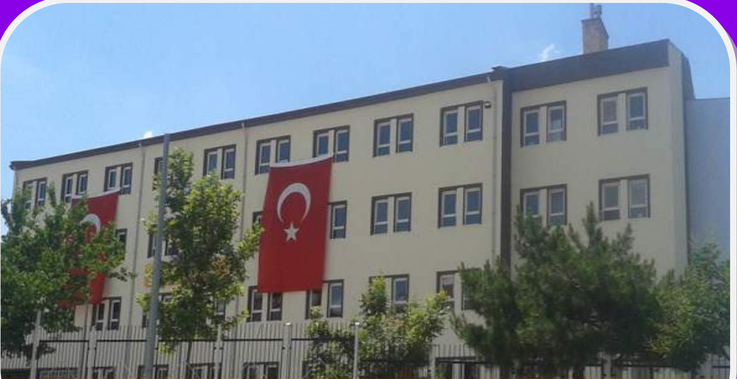
Ankara- Etimesgut Etimesgut Şehit Salih Helvacı Mesleki ve Teknik Anadolu Lisesi
